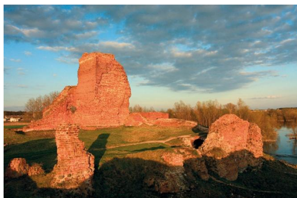
Foto 6 Ruiny zamku w Bobrownikach (fot. M. Karasiński)
